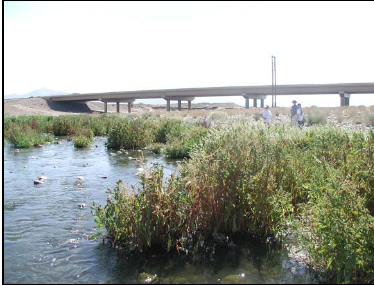
Santa Cruz River Low flow channel – Tres Rios del Norte
