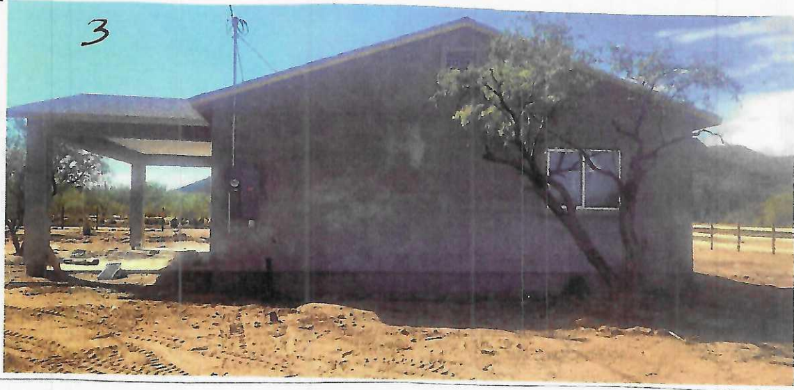
Back Side (N. Side looking So) 10/10/2024
