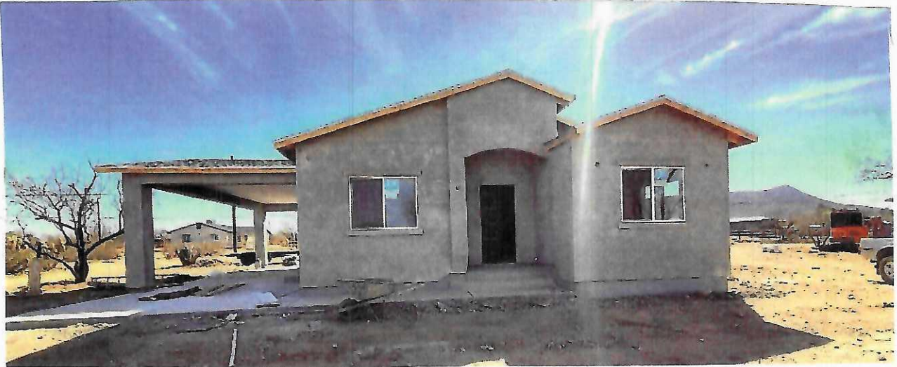
Unit 1 Front Side Unit 1 (N. Side looking So.) 2/28/2025
